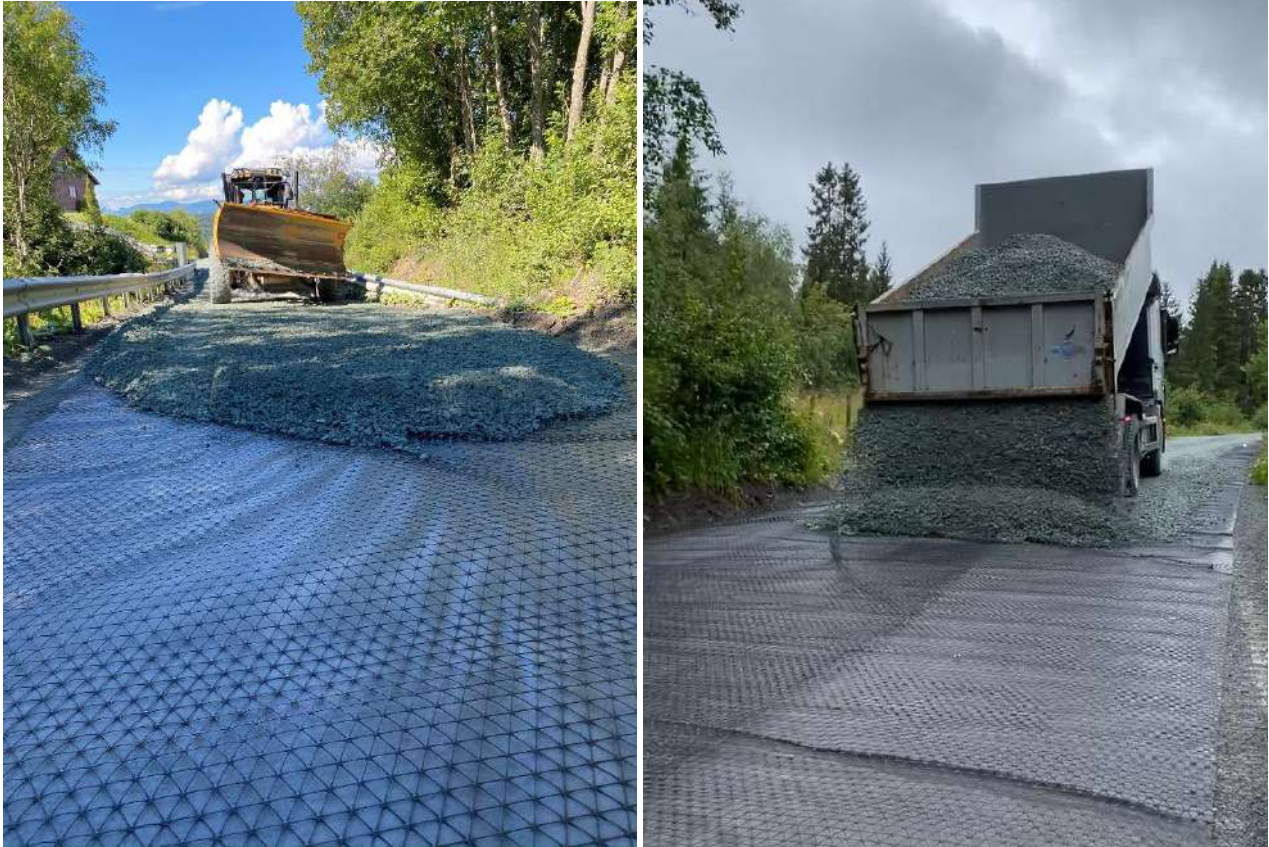
Figur 11. Utlegging av bærelag over fiberduk og geonett.
