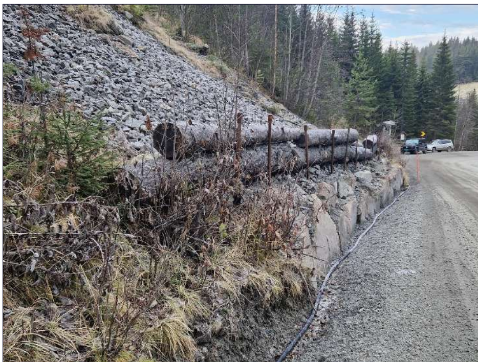
Figur 14. Dagens sikring av skråning
