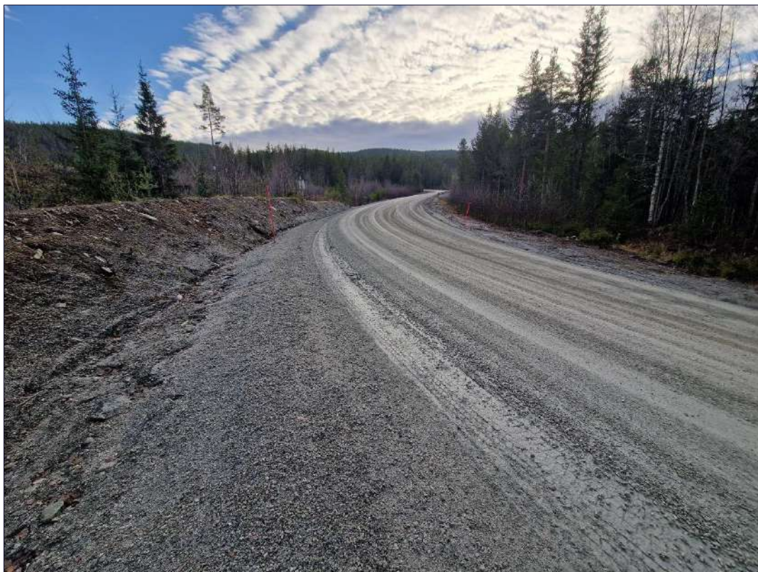
Figur 8 Toppdekke med sortert løsmasse der grusinnholdet er vesentlig større enn for de knuste massene.
